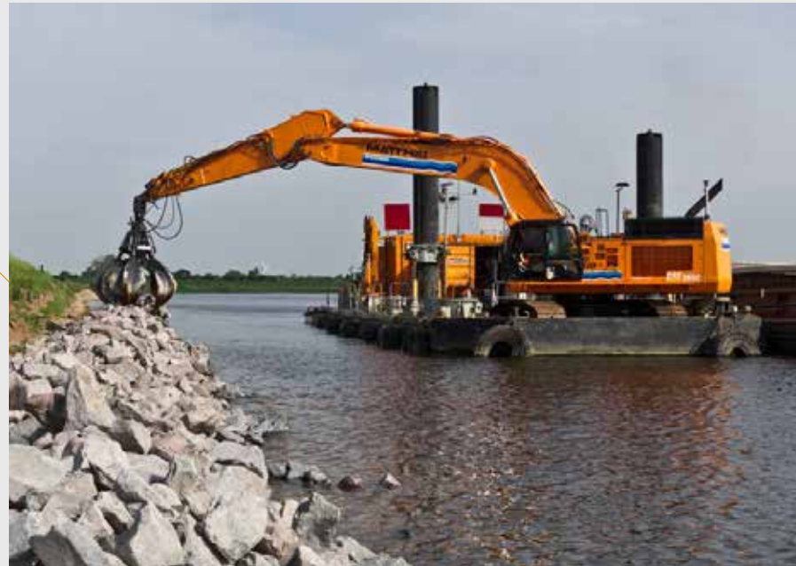
LANGWEDEL, UFER- UND NASSBAGGERARBEITEN I.Z. DER STAUHALTUNG LANGWEDEL
