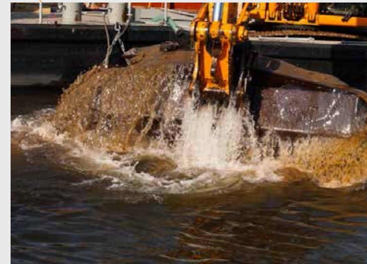
Arbeiten an der Kanalböschung werden vom Arbeitsponton aus durchgeführt.
