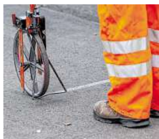
Hilfslinien für die Fahrbahnmarkierungen werden gezogen.
