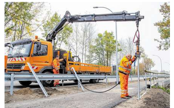
Marvin Betsch (links) und Hans-Jürgen Klindworth rammen Pfähle.
