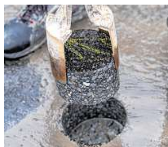
Proben für die Asphaltprüfung werden entnommen.
