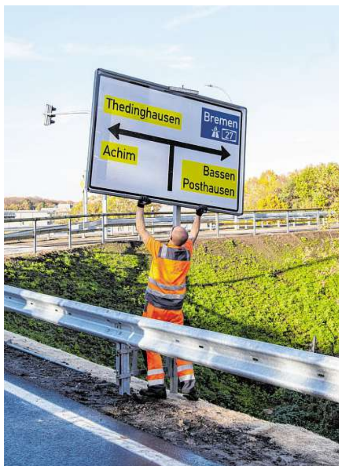
Am Freitag wurden noch die Richtungsschilder angebracht.
