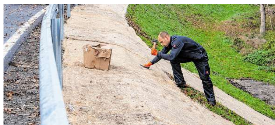
Landschaftsbauer Hannes Baasner verlegt spezielle Matten, die das Abrutschen der Böschung verhindern sollen.
