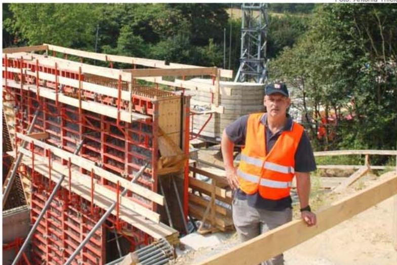
Bautechniker Mirko Repenning steht an dem Abgrund, an dem die B 404 bald mit der neuen Brücke weitergeführt werden soll
