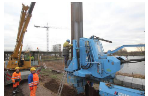
Offizieller Baubeginn mit dem ersten Rammschlag für den neuen Hochwasserschutz an der Schleuse in Geesthacht.
