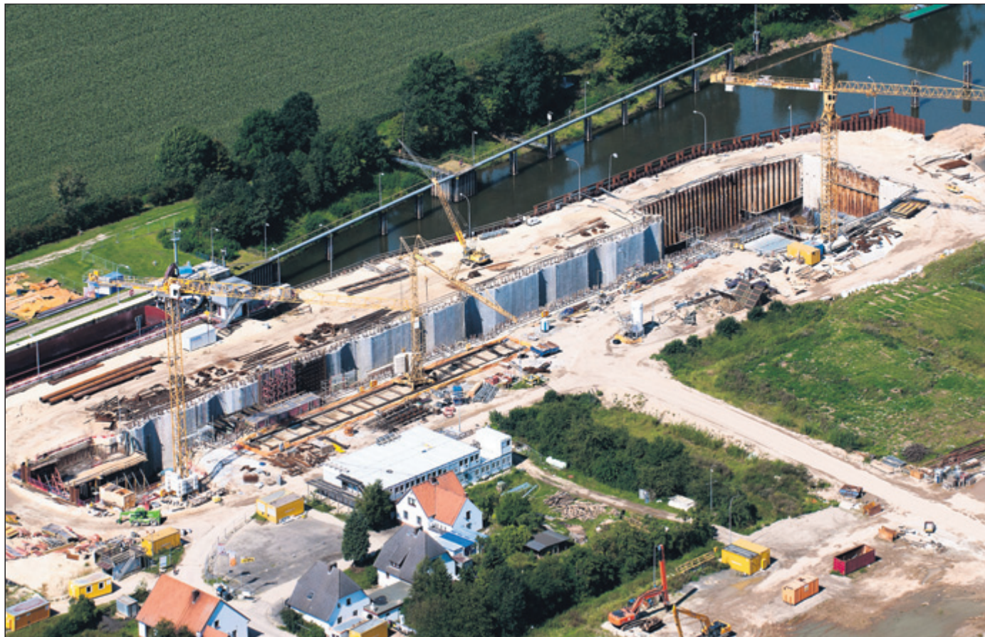
Blick in die Schleusenbauteile (von links) Oberhaupt, Kammer und Unterhaupt. Ende 2012 soll das Projekt fertig sein.
