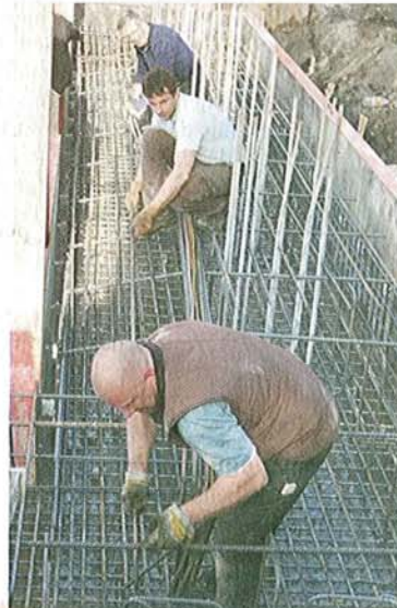
Knapp zehn Tonnen Eisen verarbeiten die Flechter zur Bewehrung eines Fundaments.
