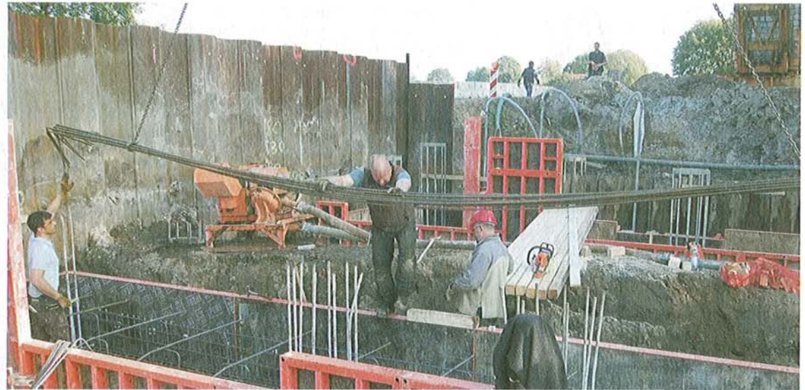
Das Geschehen in der Baugrube auf der B 321 bei Friedrichsruhe bleibt Vorbeifahrenden nahezu verborgen. FOTOS: RÜDIGER RUMP
