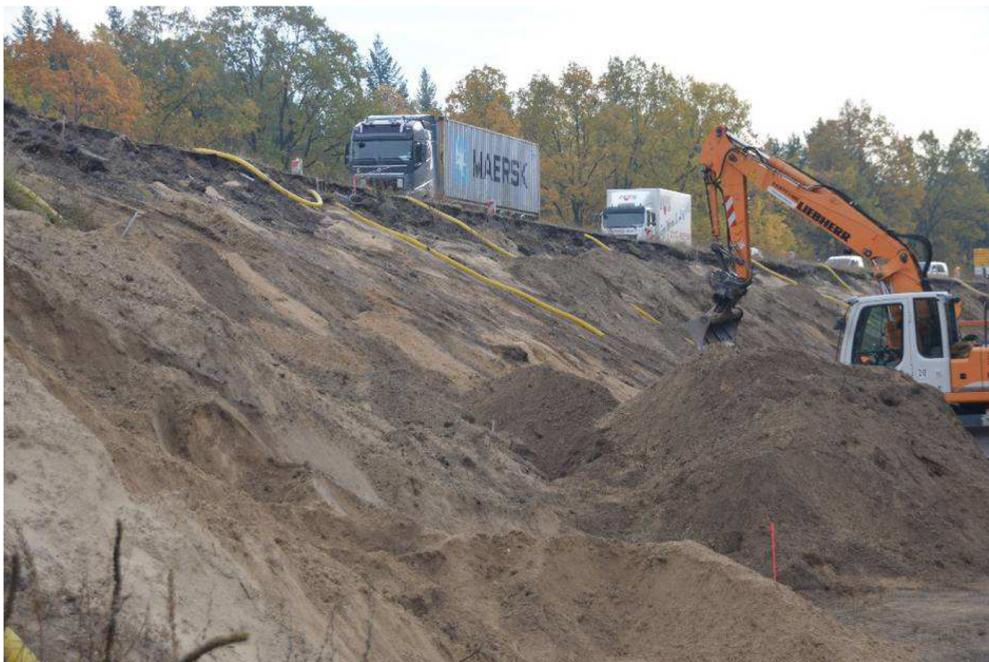
Schadensbeseitigung: Die abgesackte Böschung an der L 191 an der Anschlussstelle zur B 96 in Sachsenhausen wird mit neuem Material flacher wieder aufgebaut.
